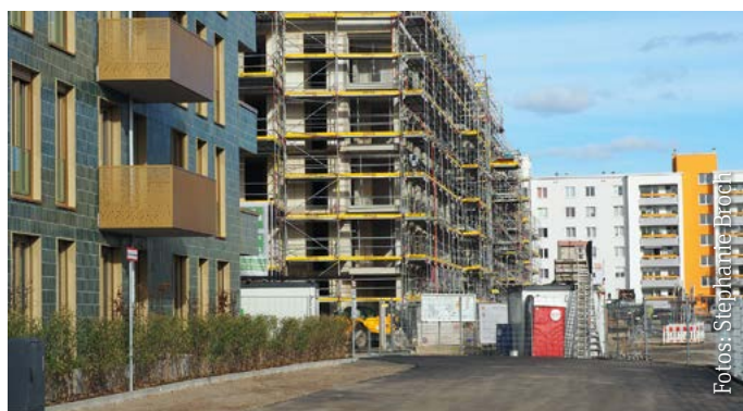
Noch wird im neuen Quartier gebaut, 2028 soll es fertiggestellt sein.
