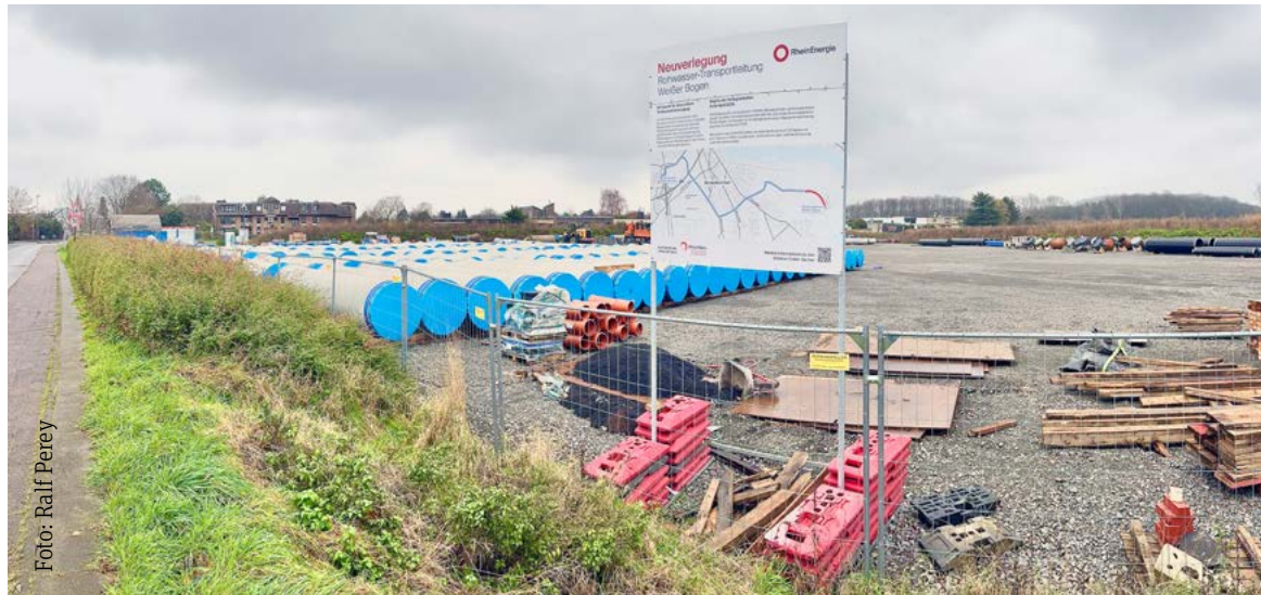
Das Lager der Rohwasser-Transportleitungen für die Trinkwasserversorgung in Köln-Weiß.
