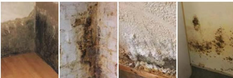
Defekte Horizontalsperre    Querdurchfeuchtung    Ausblühungen    Schimmelbefall
