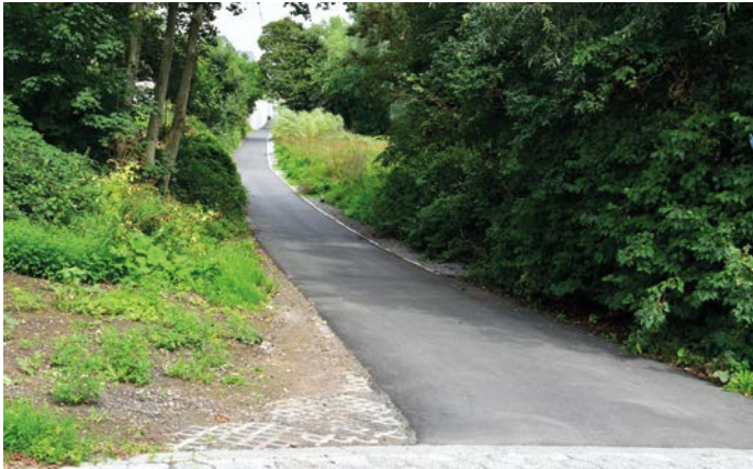
Sürth, sanierter und verbreiteter Rad-/Fußweg auf dem Leinpfad zwischen Panzerrampe und Bootshaus.
