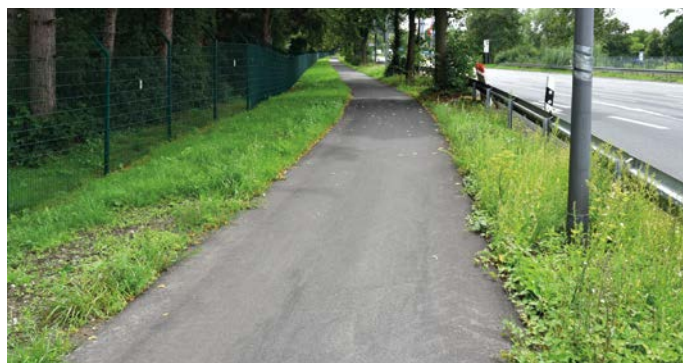
Godorfer Hauptstraße, im vorderen Abschnitt bereits vorzüglich sanierter Rad- und Fußweg.
