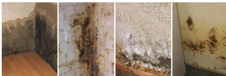
Defekte Horizontalsperre
