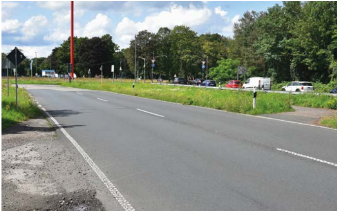
Gefahrvolle Querung Rad-/Fußweg Militärringstraße östlich des Verteilerkreises.
