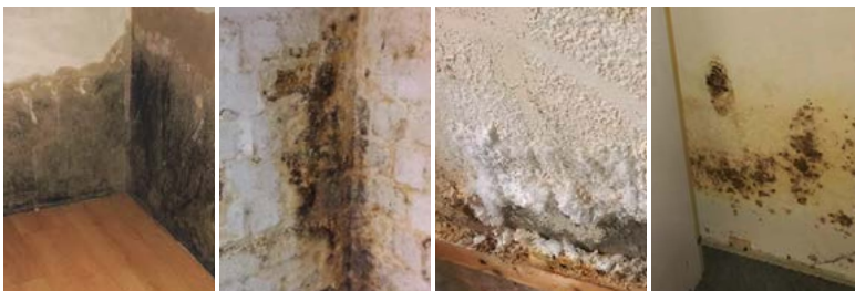
Defekte Horizontalsperre Querdurchfeuchtung Ausblühungen Schimmelbefall
