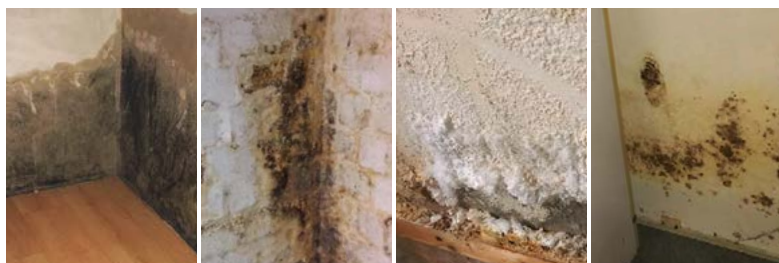
Defekte Horizontalsperre Querdurchfeuchtung Ausblühungen Schimmelbefall
