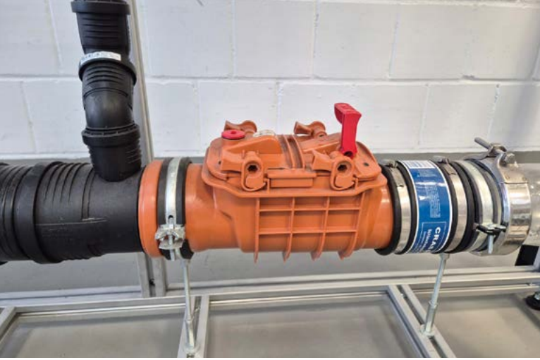
(v.l.) Mechanische Rückstauklappe. Elektrische Rückstauklappe. Fotos: Innung SHK Köln.
