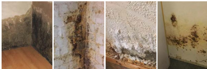
Defekte Horizontalsperre
