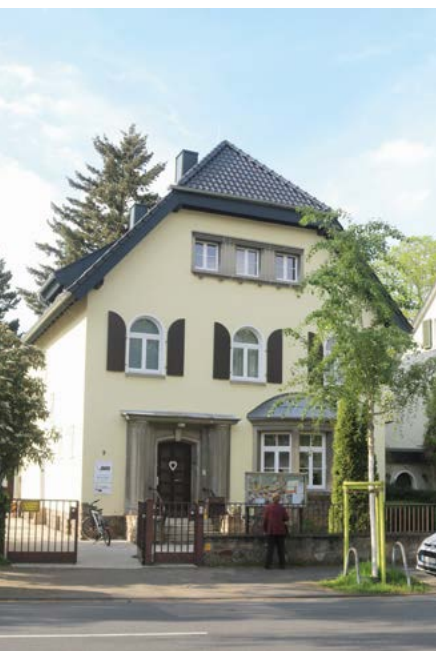
Das ist die „Villa AWO“ in der Walther-Rathenau-Straße 9 in Rodenkirchen. Foto: Thielen.
