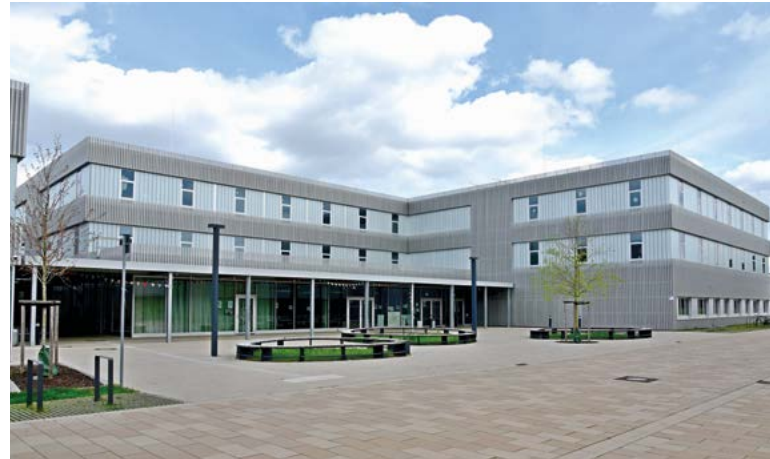
Ansicht der Offenen Schule Köln, mit Haupteingang. Foto: E. Broch.
