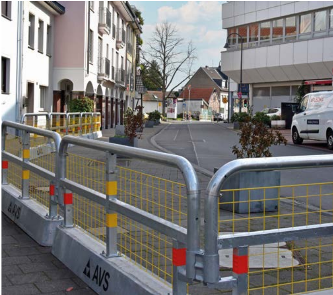
Auch in der BarbarasträÙe werden die Baufahrzeuge verkehren. Hier Schutzgitter an den Ausweichstellen.
