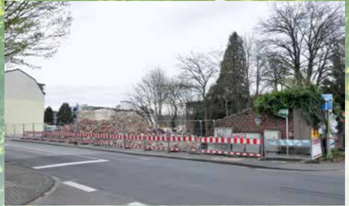
... und so zurzeit, denn der Abriss der alten Gebäude, vor allen Dingen des Hochbunkers, dauert an. Fotos: Milden.
